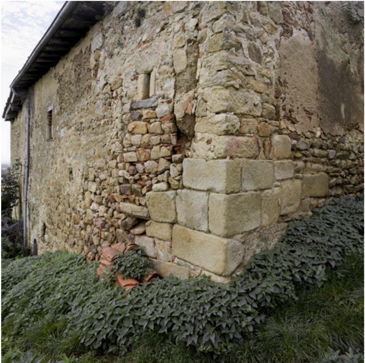
Vue de l'angle nord-ouest du bâtiment nord-est : appareillage à gros blocs.
