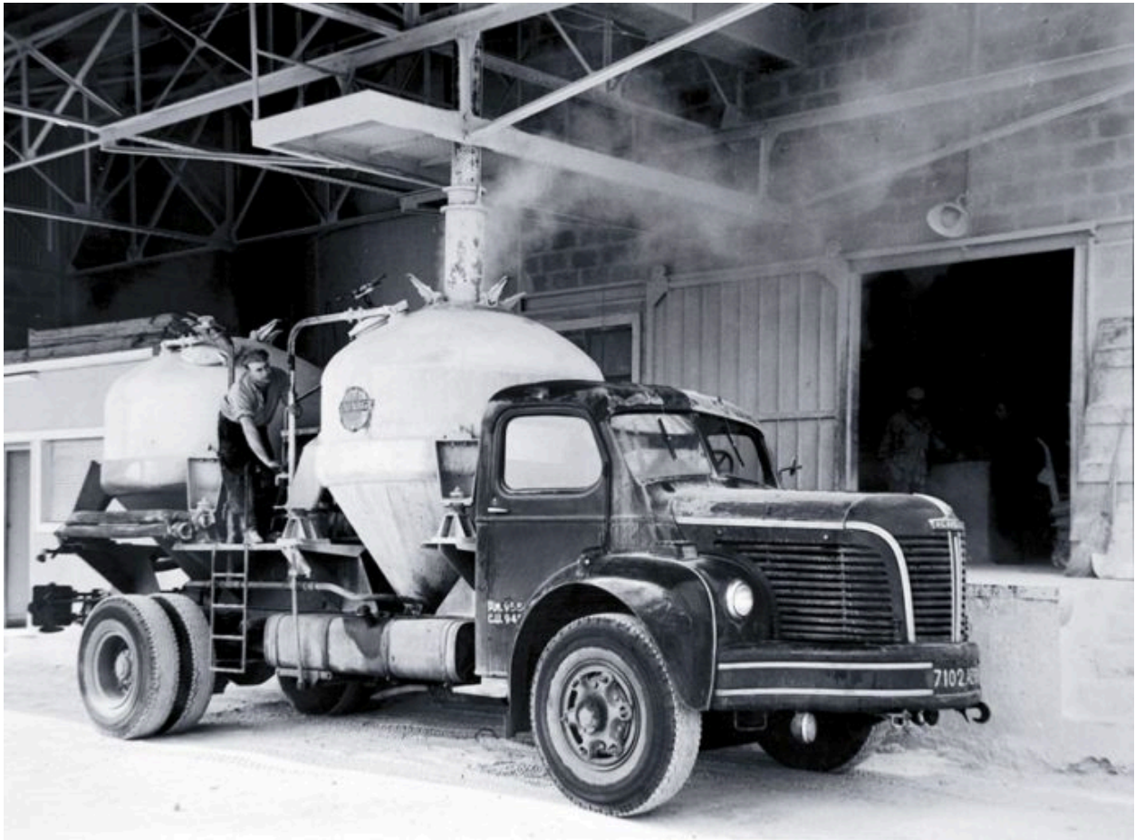
Le port Rambaud en 1952. Le chargement des camions de ciment.. photographie, 1952 Chambre de commerce et d'industrie de Lyon. S1 T1 5 n° 2
