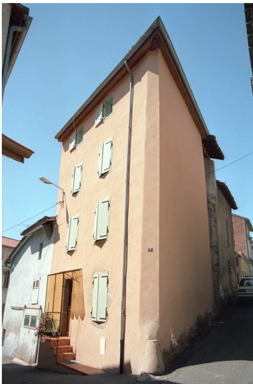
Boën, îlot 14, Veloutiers (rue des) 1. Vue générale de la façade sur rue.
