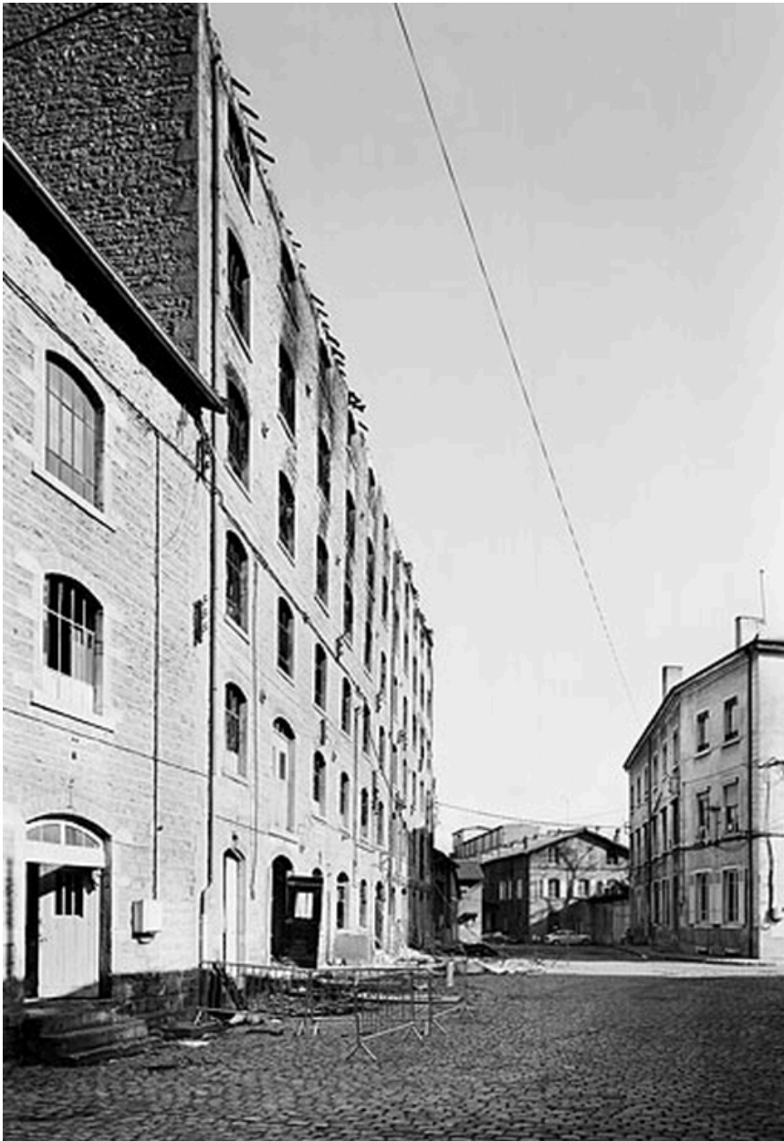
Vue d'ensemble ouest des bâtiments
