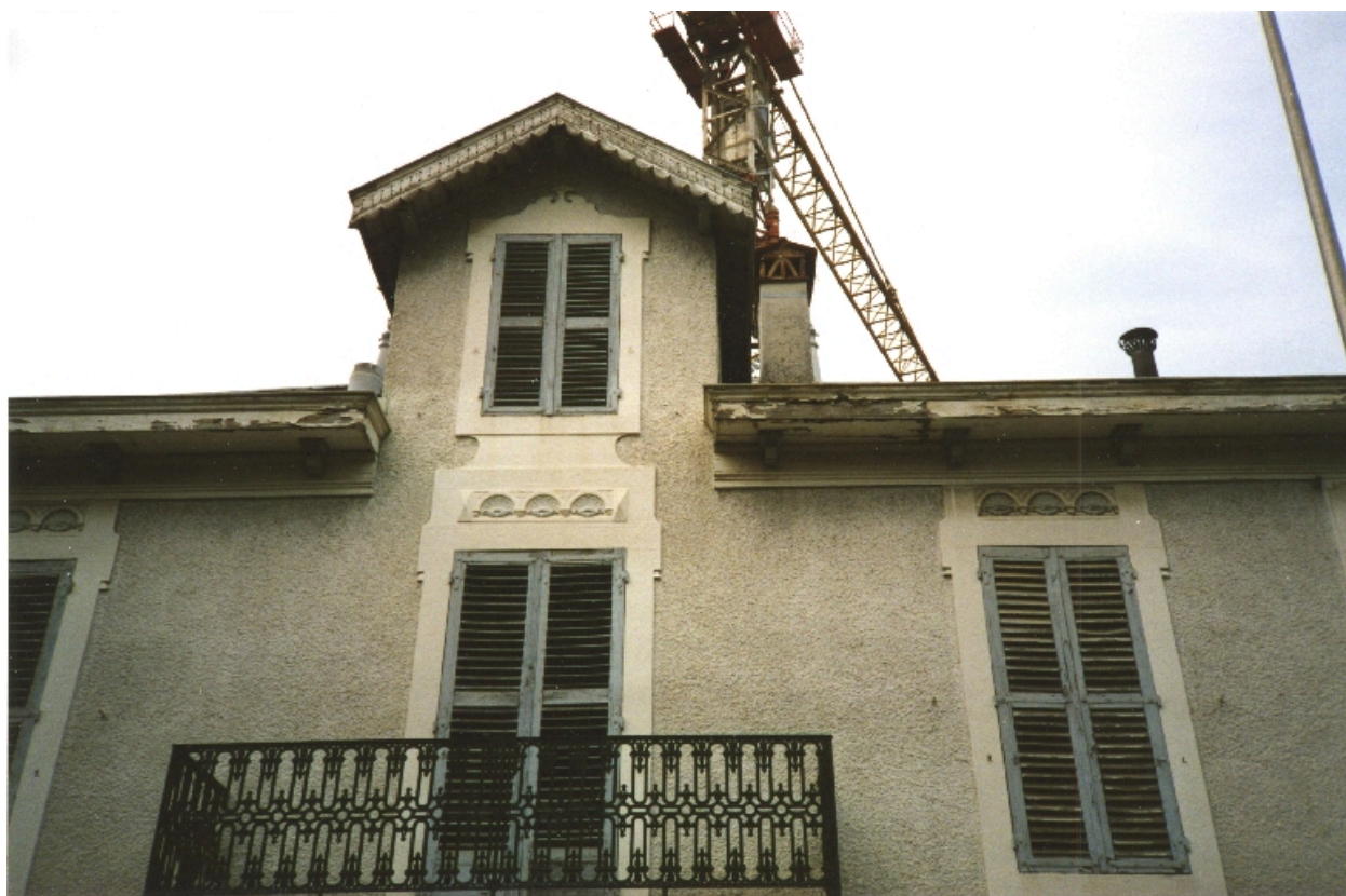
Façade sur rue, partie haute, avant démolition
