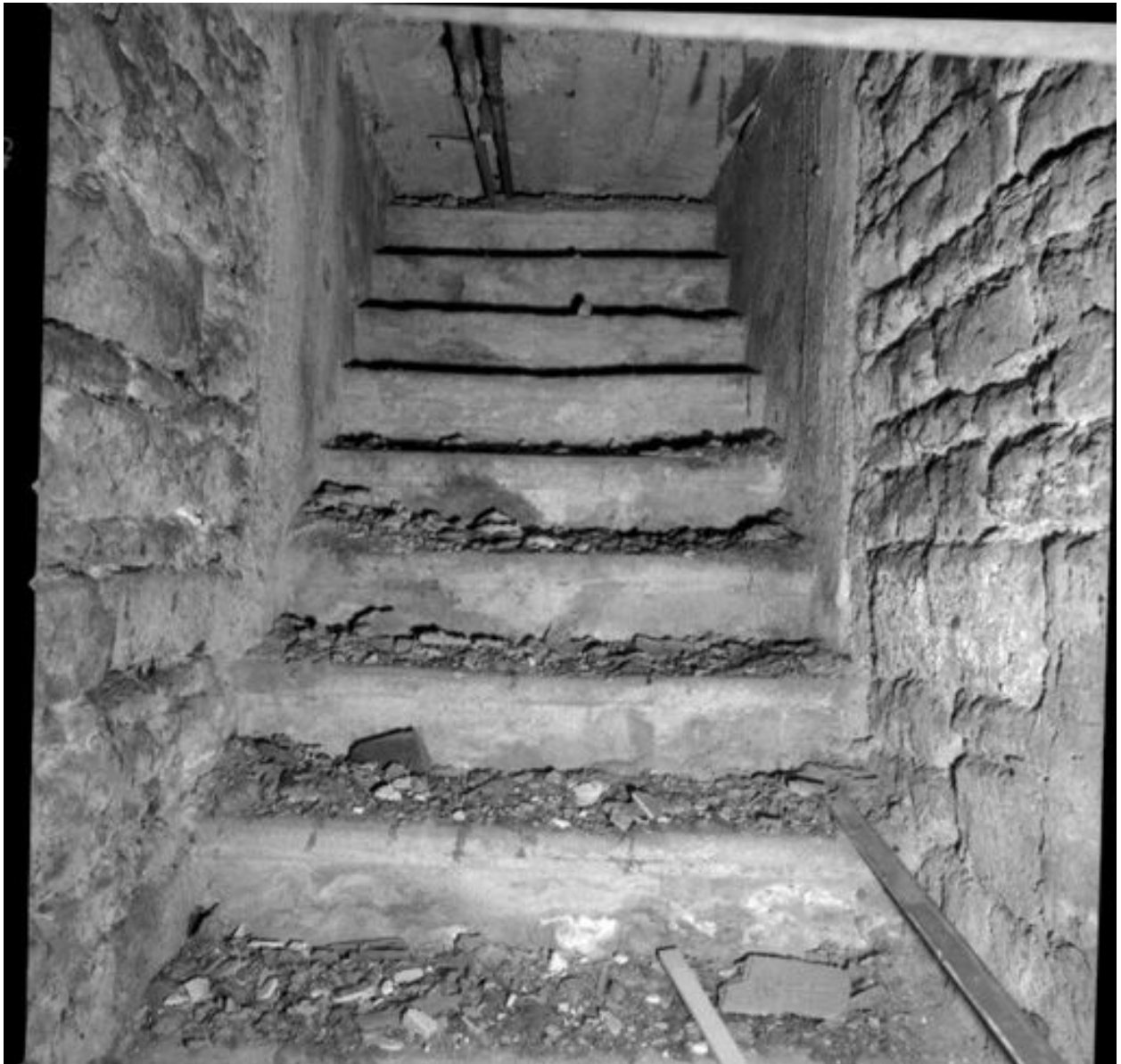
Cave sud, escalier en pierre aujourd'hui désaffecté partiellement masqué par une échelle-de-meunier
