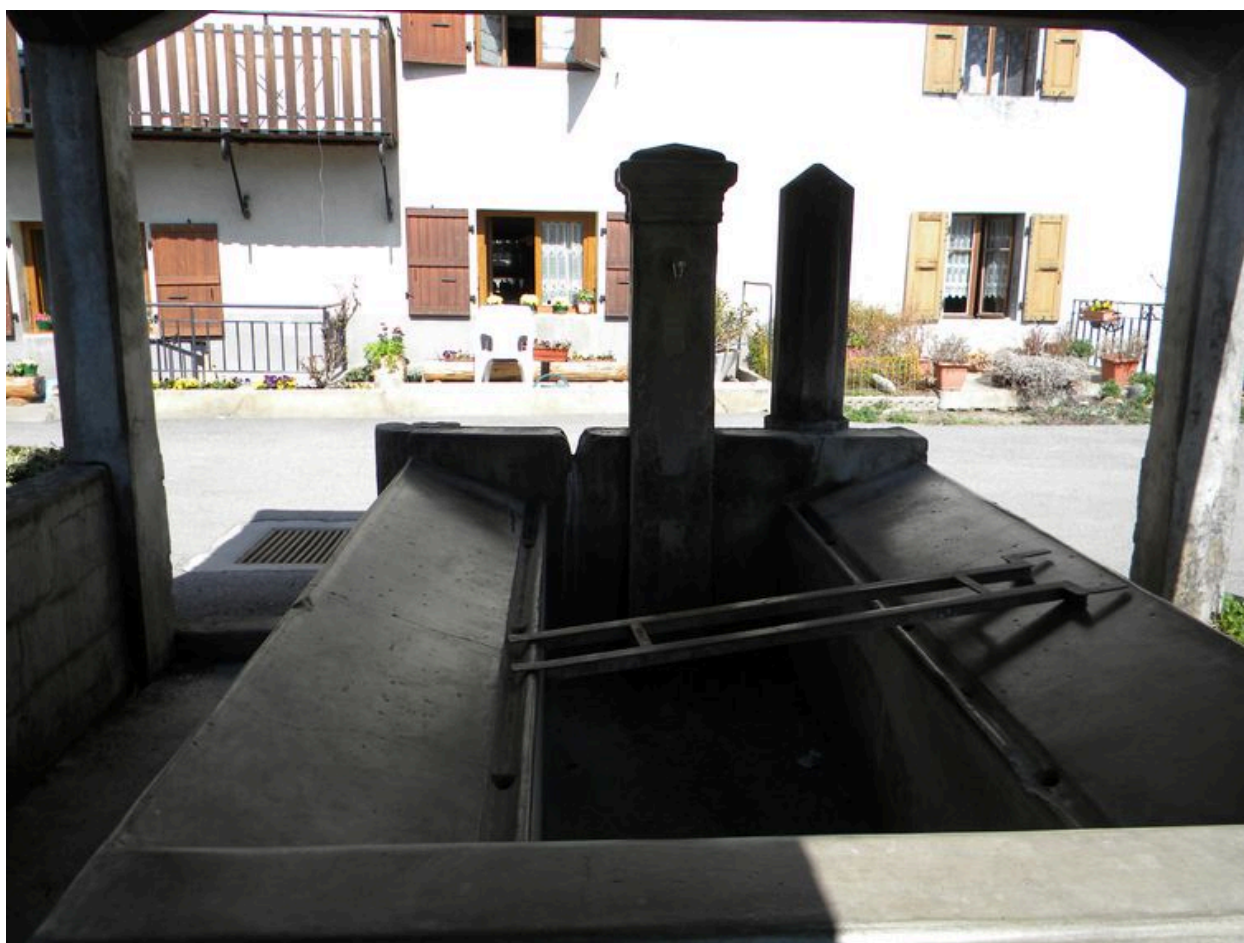
vue du lavoir sous sa couverture
