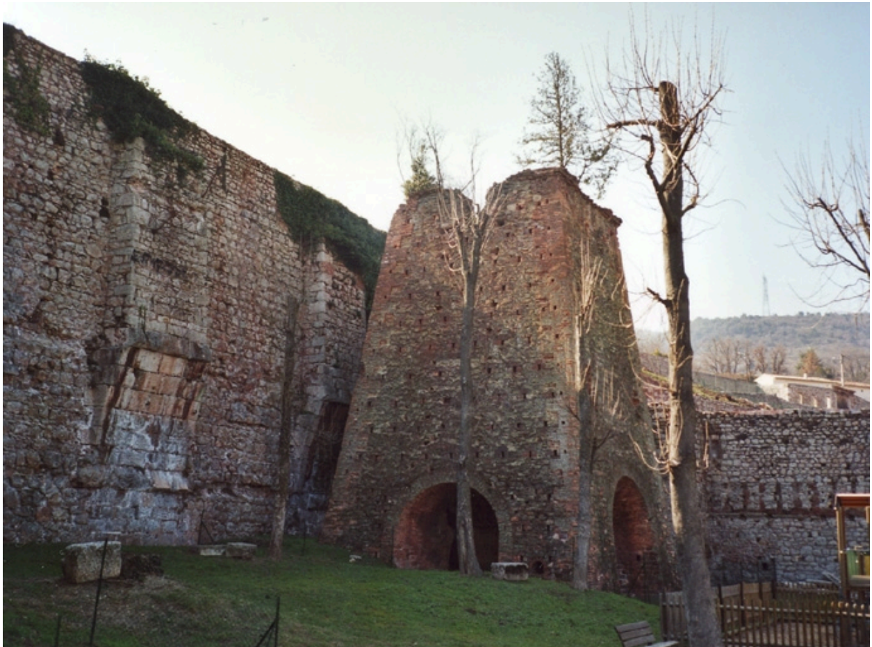
Vue est d'un haut fourneau
