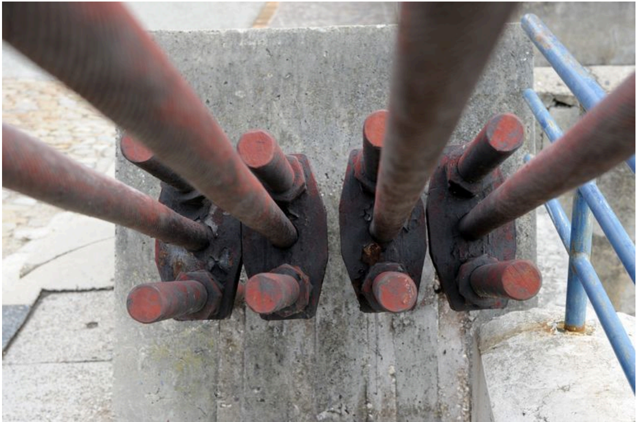
Massif d'ancrage, vue de détail : arrivée des câbles (depuis la chaussée)
