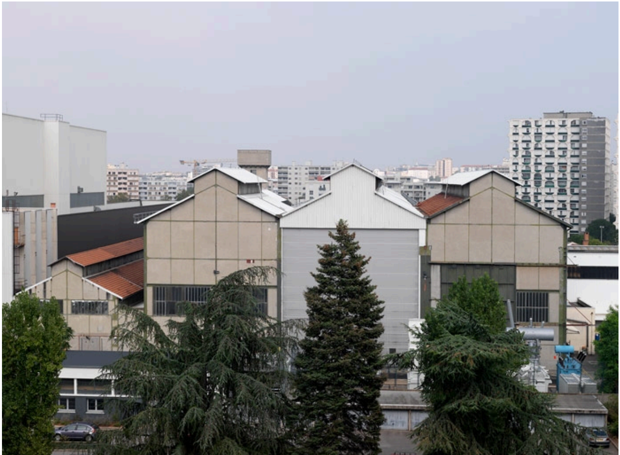
Vue sud-ouest du site : grandes halles
