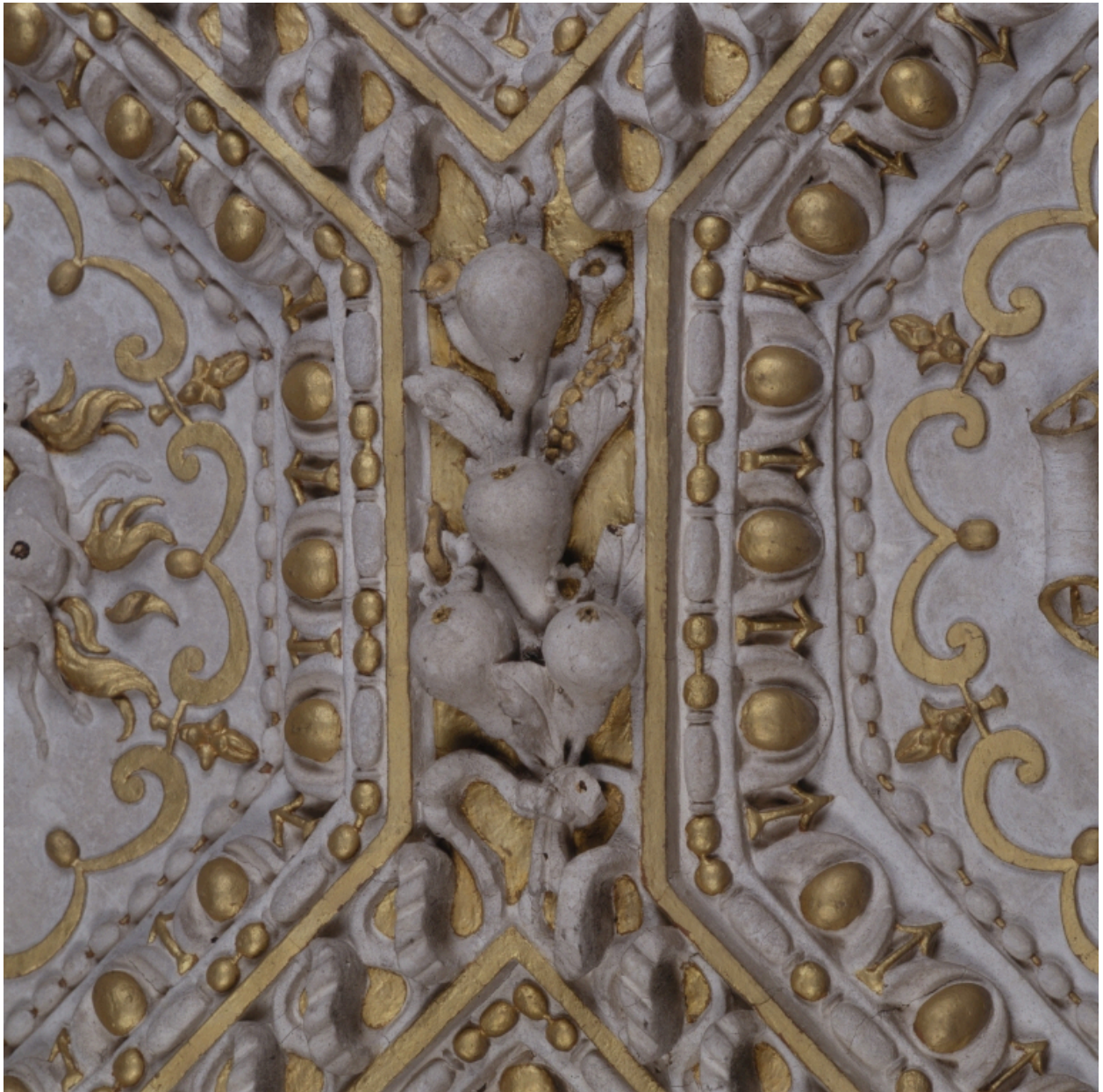
Voûtain de l'entrée, décor situé entre les caissons n°2 et n°3 : poires.
