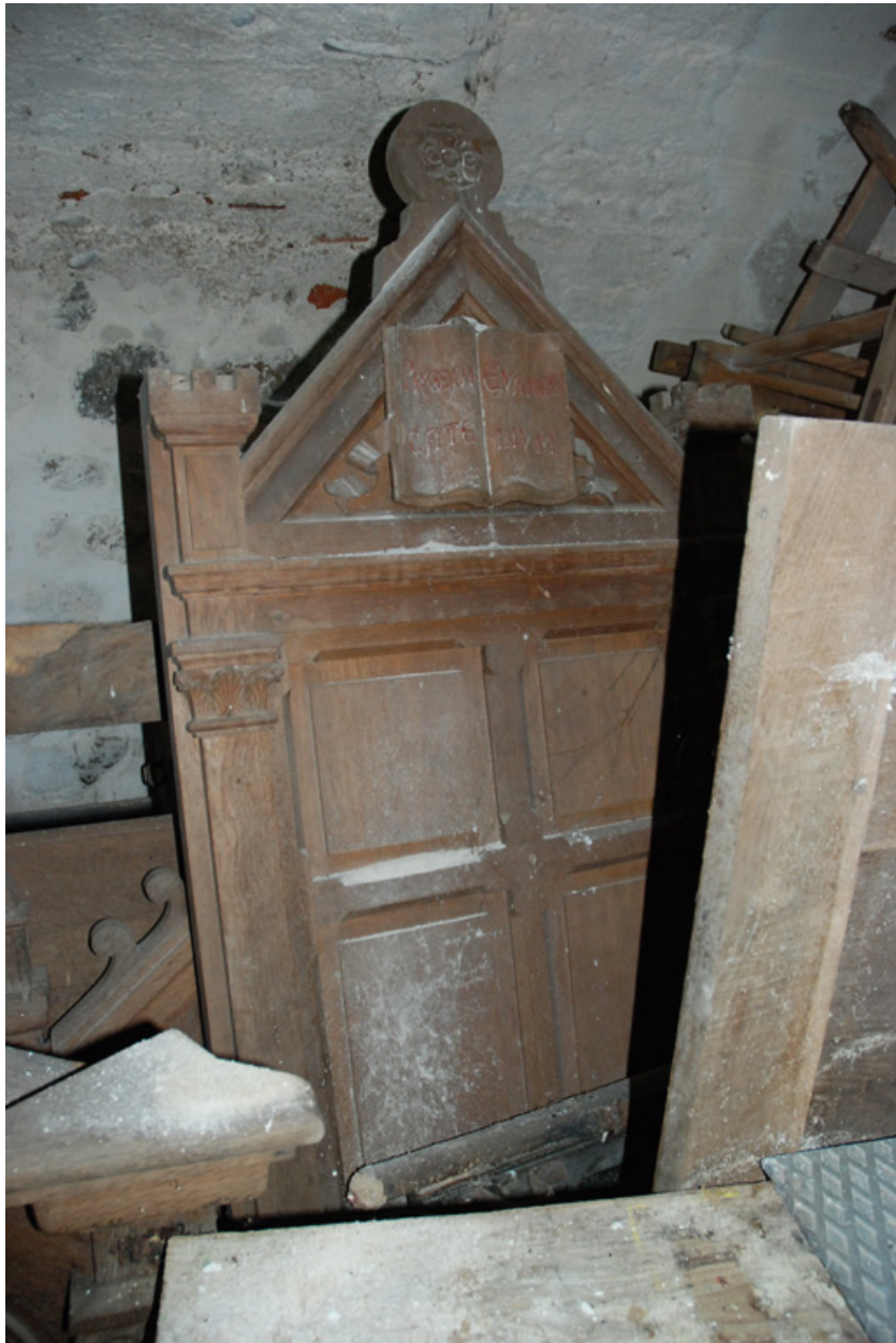
Vue du dosseret de la chaire déposé dans la cave du Paradis.
