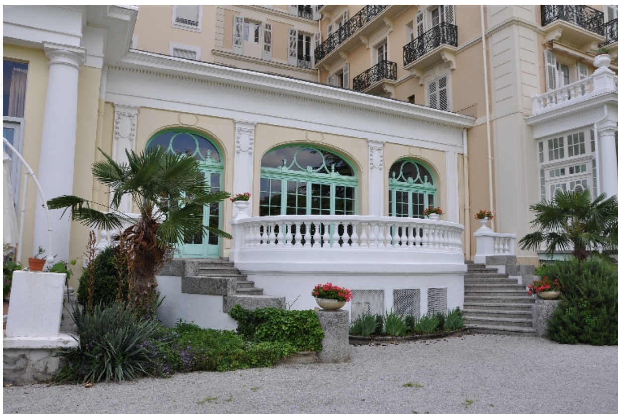
Façade et perron du hall
