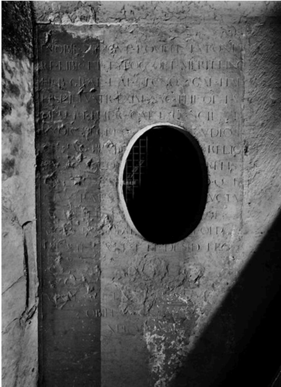
Couvent : cloître, pierre de remploi utilisée pour le départ de l'escalier nord-ouest ; le percement de l'oculus permet d'assurer l'aération de la cave
