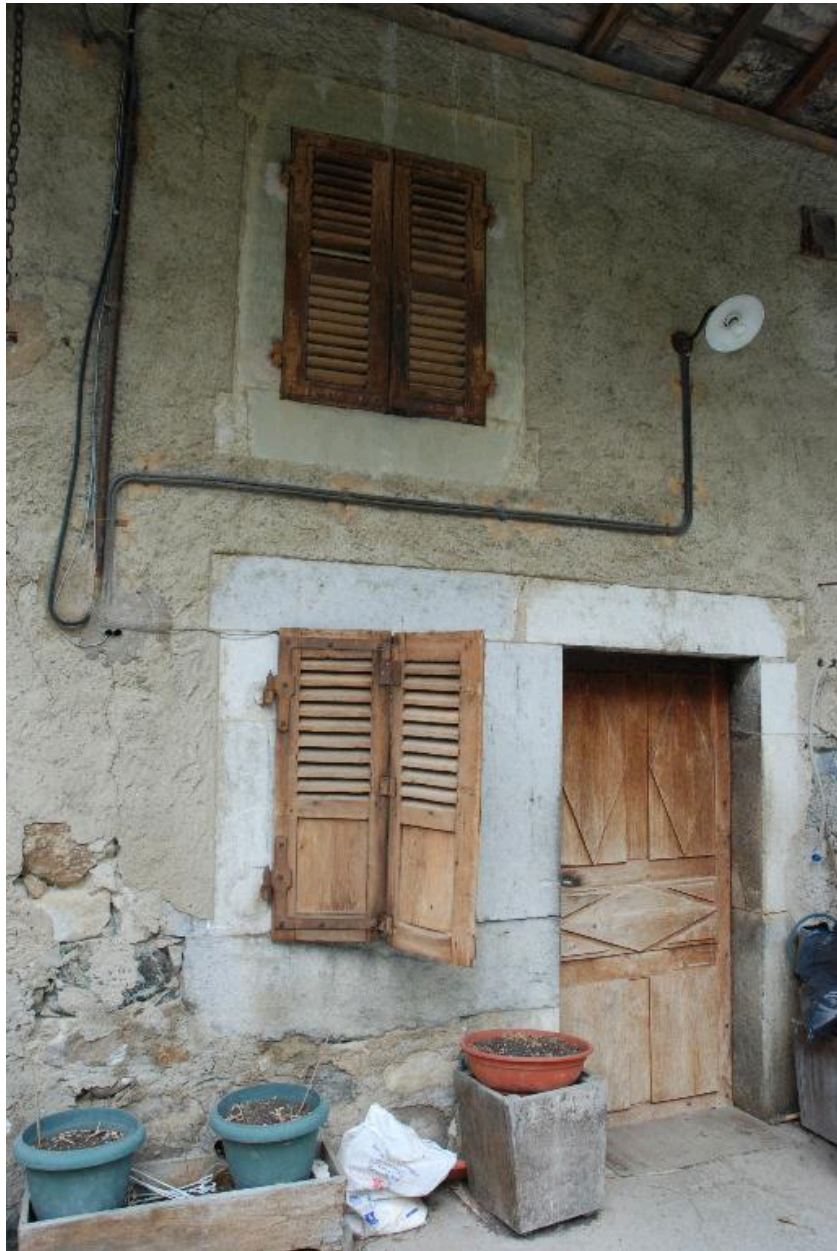
Détail de la façade de l'habitation, partie ouest.
