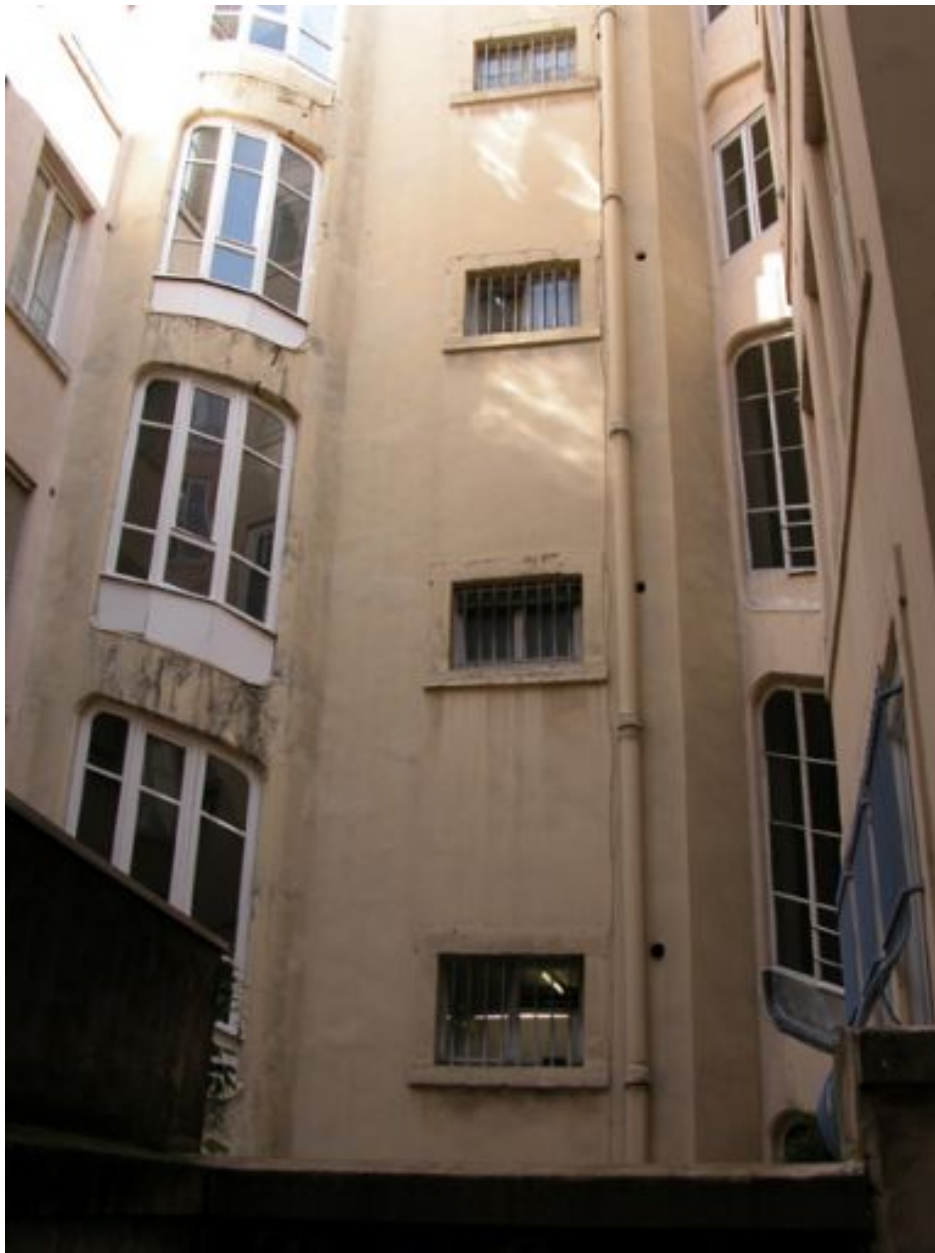
Elévation de la cage d'escalier (à gauche) et du corps adjacent (au centre) sur les cours des immeubles 21, rue Mercière et 20, rue de Brest
