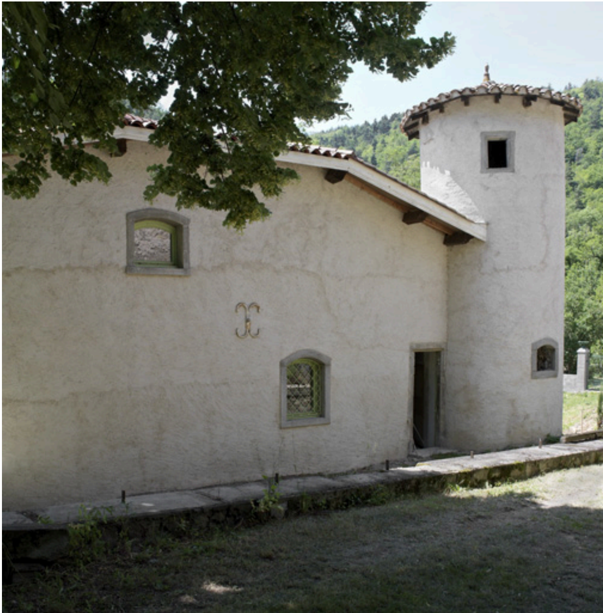
Vue de la façade nord, depuis le nord-est.
