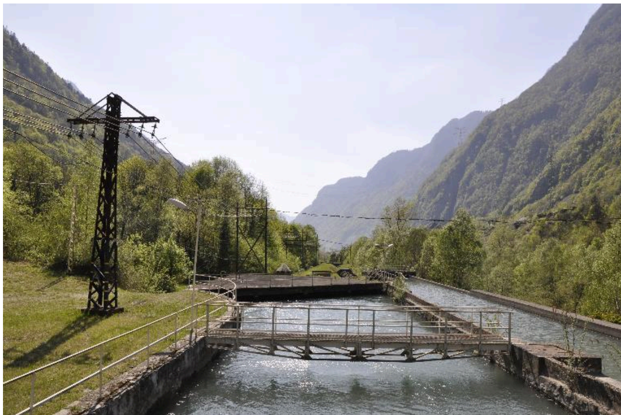
Vue du barrage
