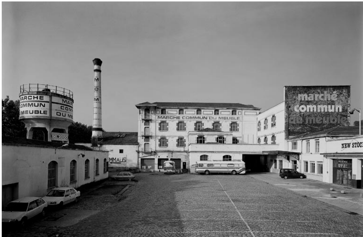
Vue d'ensemble de la cour d'entrée, bâtiment des semouleries en premier plan, à l'est atelier menuiserie
