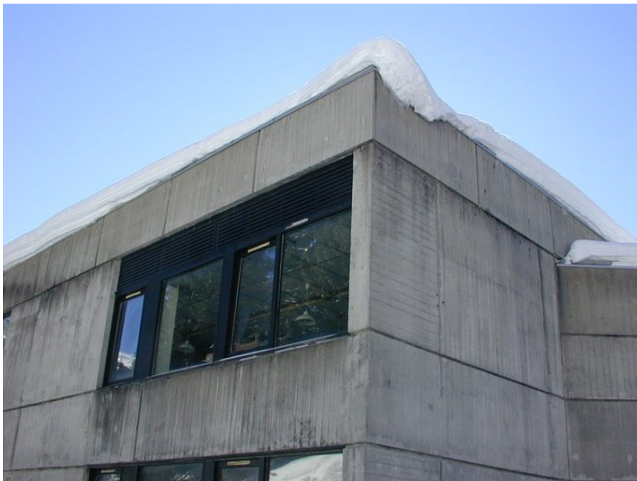
Le bâtiment d'entrée avant réfection. Détail de l'angle nord-ouest (façade postérieure)
