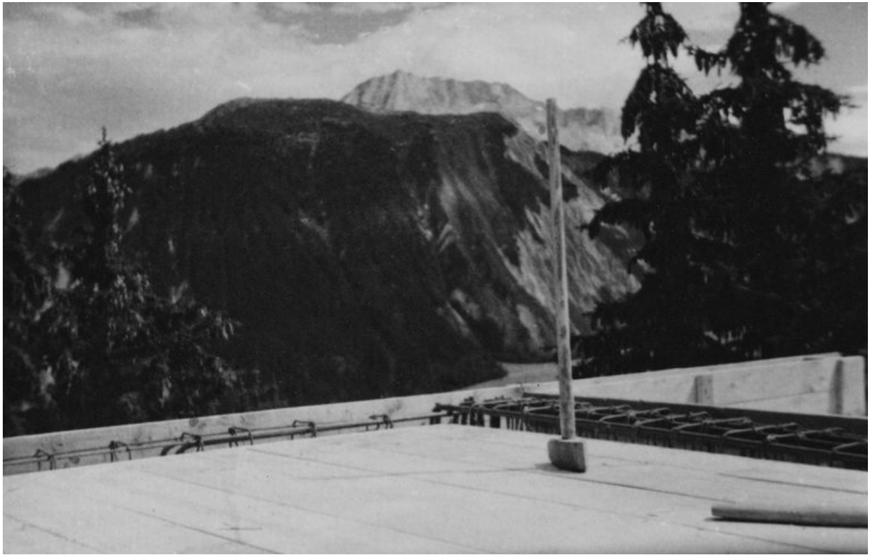
Le chalet en construction. La dalle de béton. Photogr. Denys Pradelle, [1950] (AD Savoie. 6J 100)
