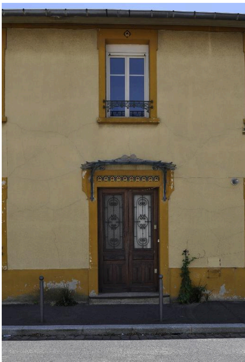
Vue rapprochée de l'élévation sur rue, travée centrale
