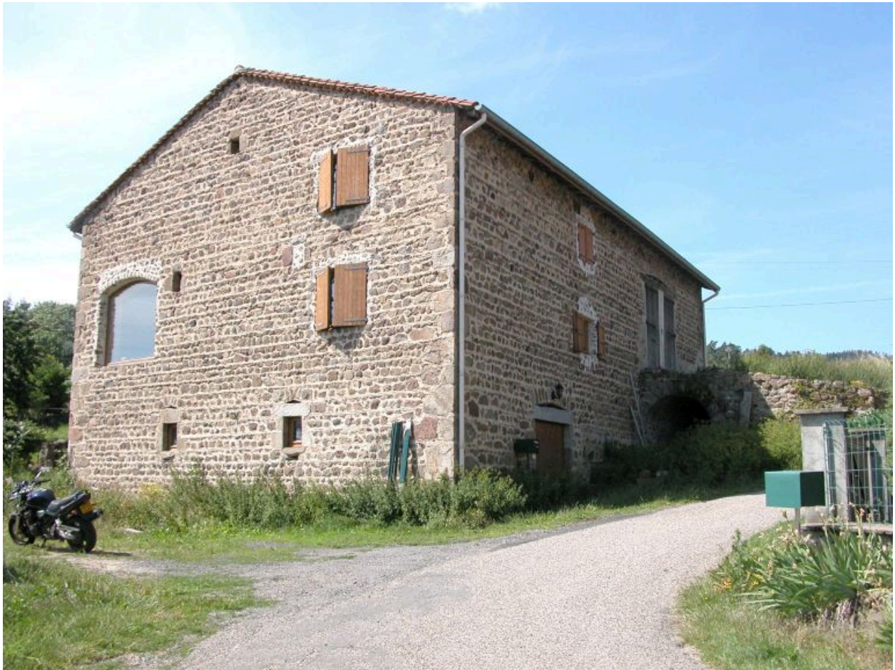
Condamine (1986 AK 257). Grange-étable, vue d'ensemble.
