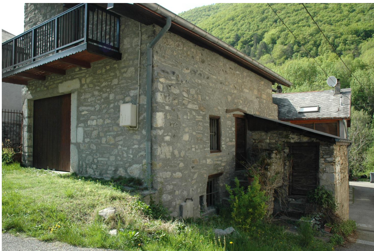
Maisons de vigneron (2018 A5 1037, 1030), escalier extérieur en pierre.
