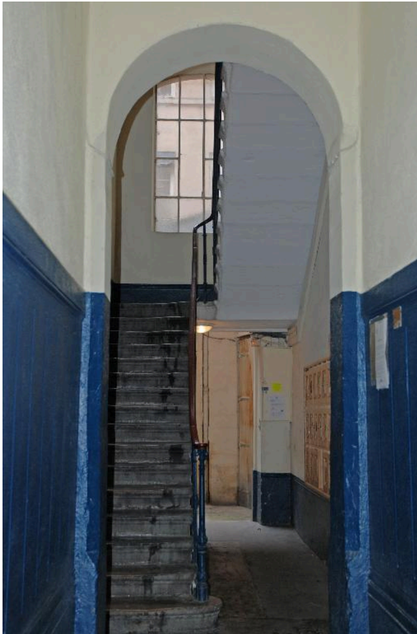
Immeuble sur rue : allée et départ de l'escalier
