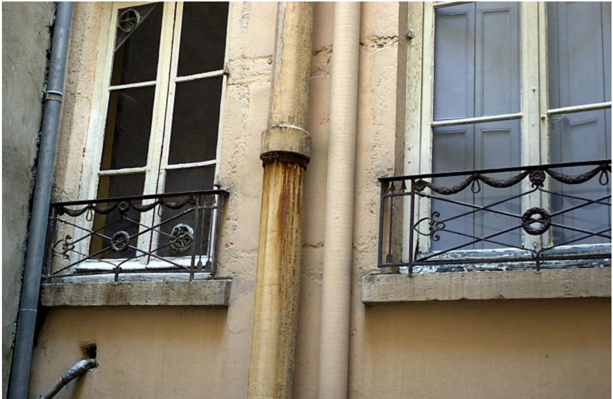
Façade sur cour, détail des appuis de fenêtre
