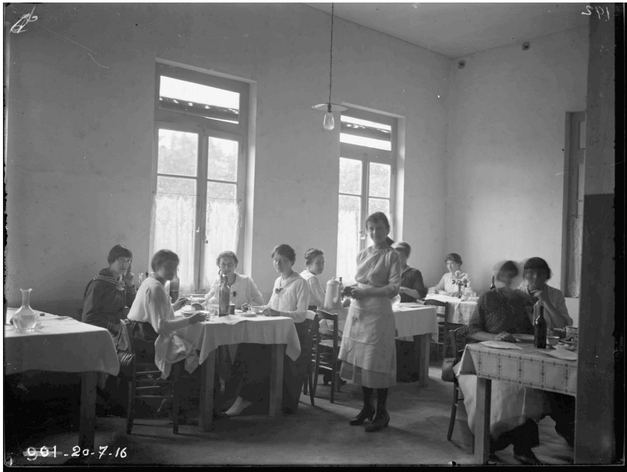
Vue intérieure de l'usine, vers 1920, AD 69 : série 158 J. plaque de verre, usine Tréfimétaux AD Rhône. 158 J
