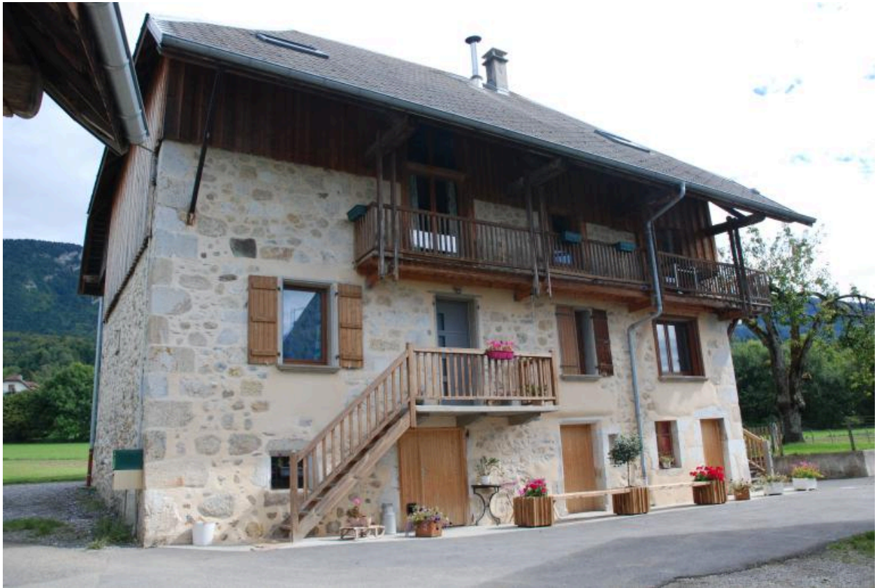
Vue d'ensemble de la maison d'habitation de face.
