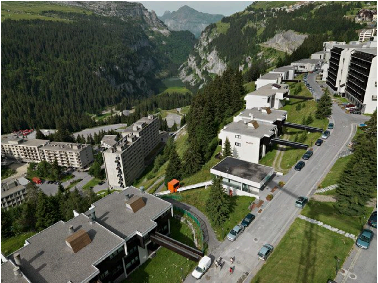
Vue d'ensemble de la partie ouest de la station et ouverture sur la vallée
