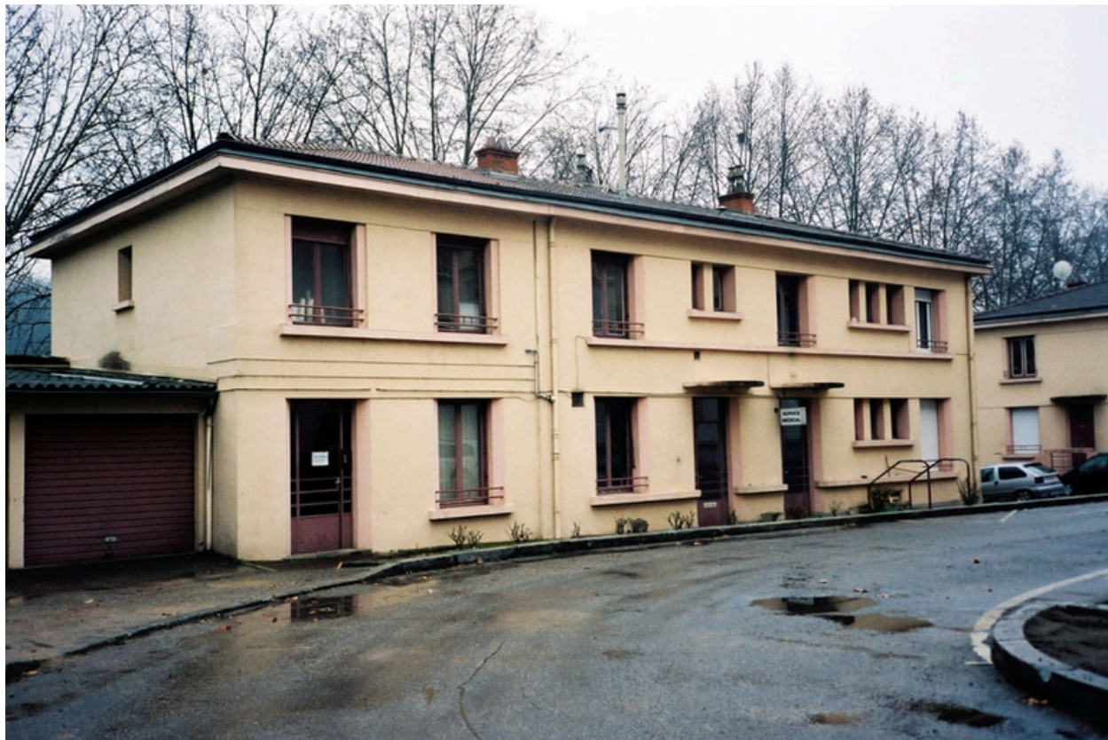
Détail extension du second pavillon
