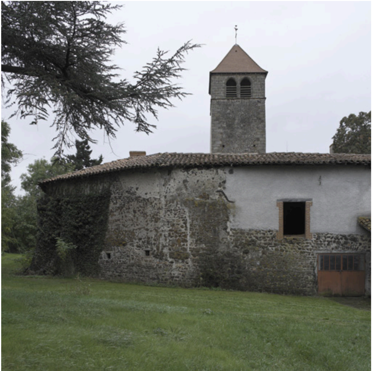
Vue de l'angle nord-est de la basse cour, depuis le nord (grange-étable, clocher de l'église).
