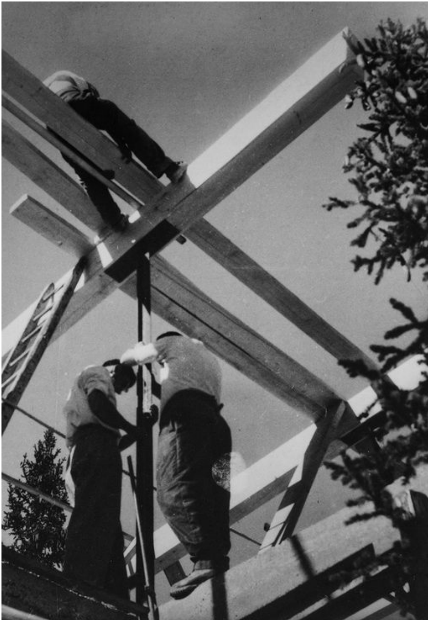
Le chalet en construction. Montage de l'ossature. Photogr. Denys Pradelle, [1950] (AD Savoie. 6J 100)
