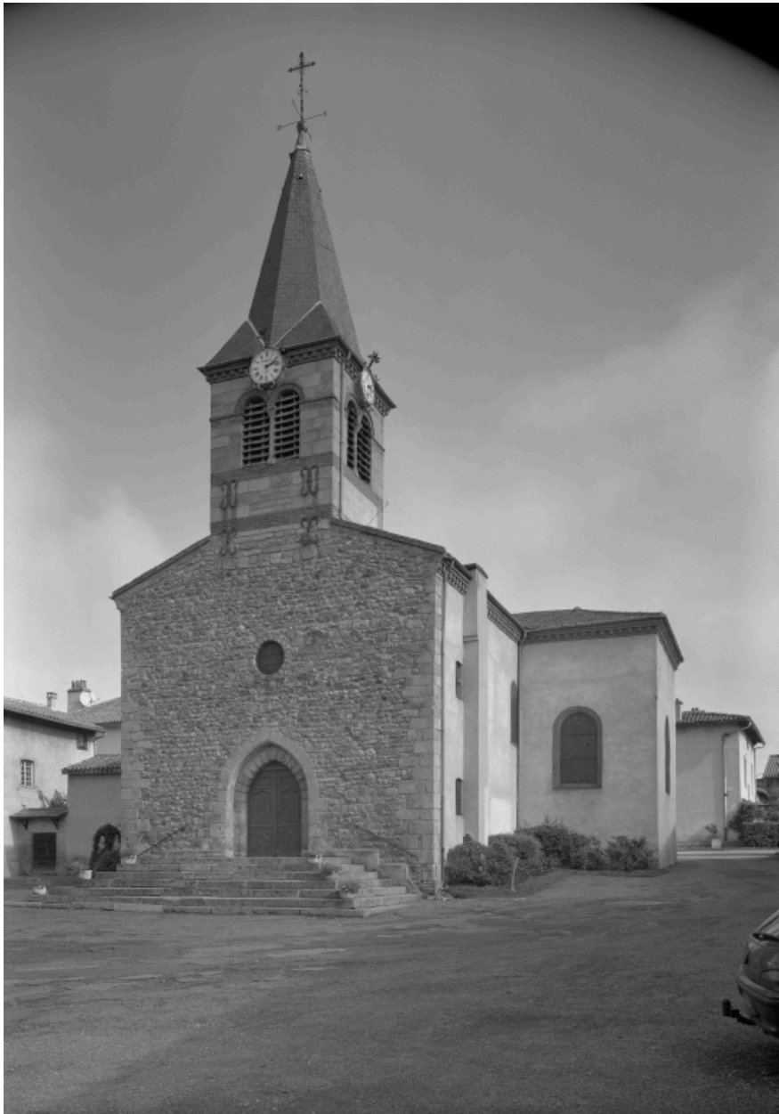
Vue d'ensemble des élévations sud et ouest de l'église
