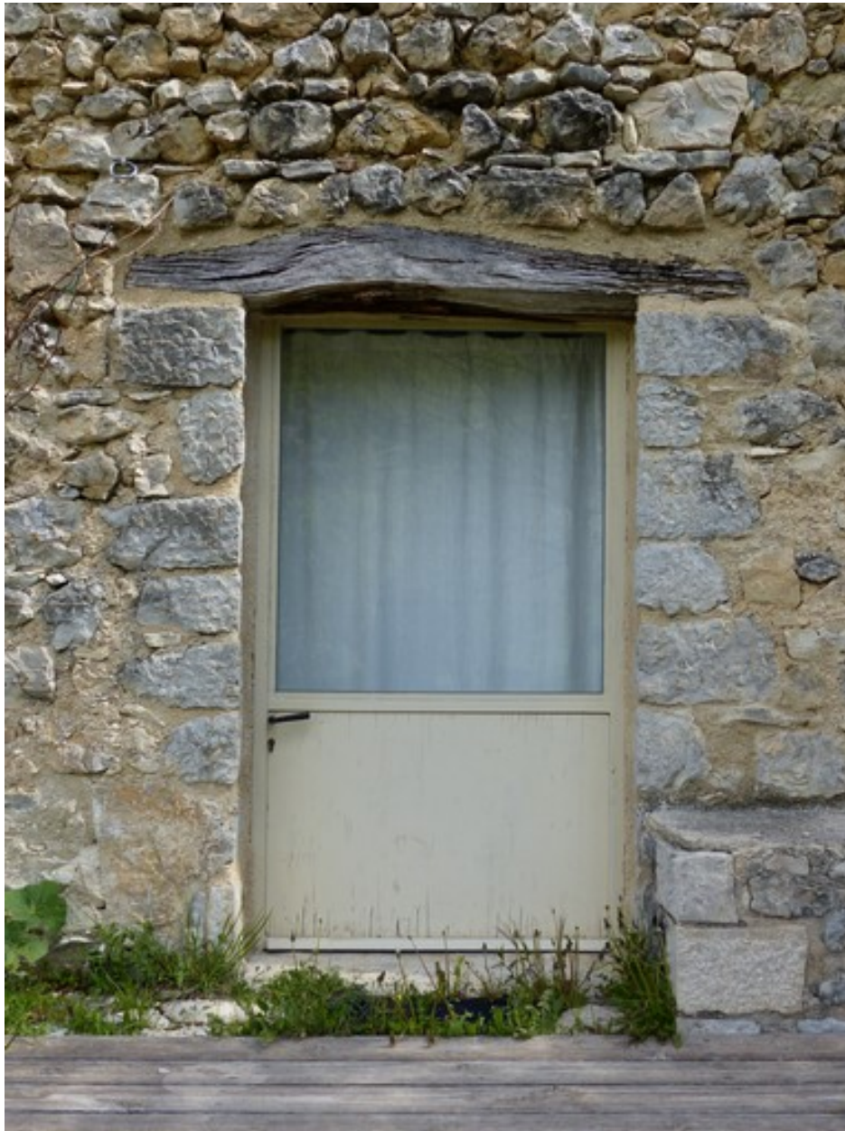
Elévation sud, premier niveau. Porte de l'étable.
