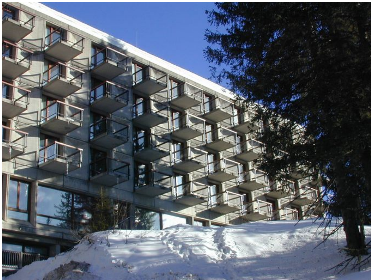
Elévation principale, à l'est
