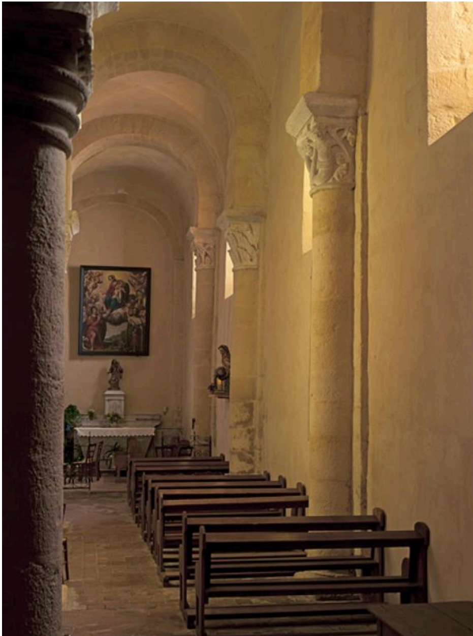
Bas-côté sud en direction de l'est.
