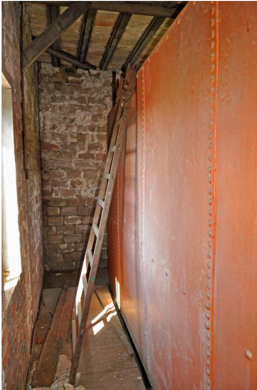
Château d'eau, vue intérieure : la cuve en fonte rivetée
