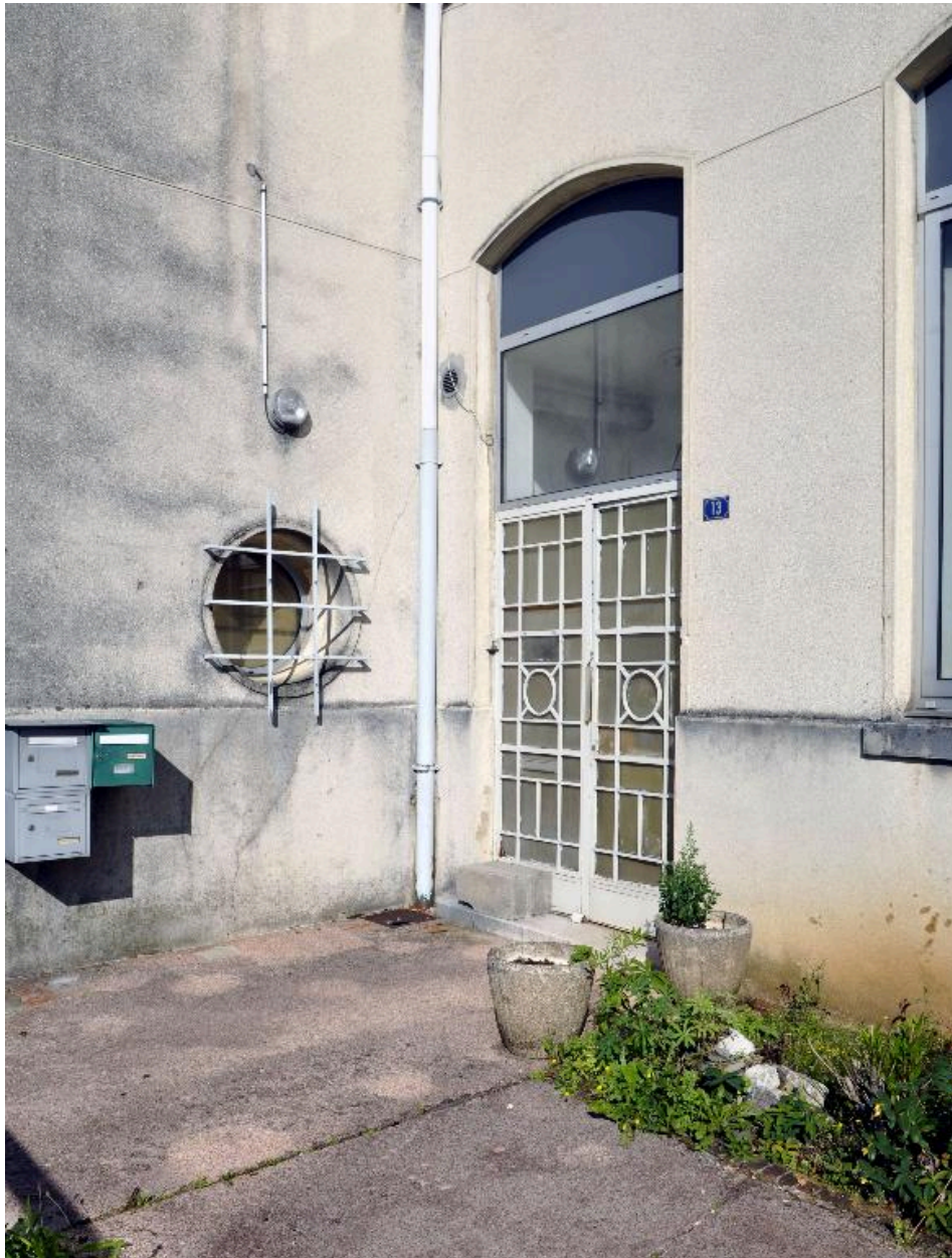
Élévation principale : entrée latérale
