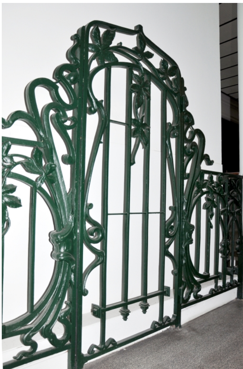
Corps principal : ancienne grille de l'ascenseur
