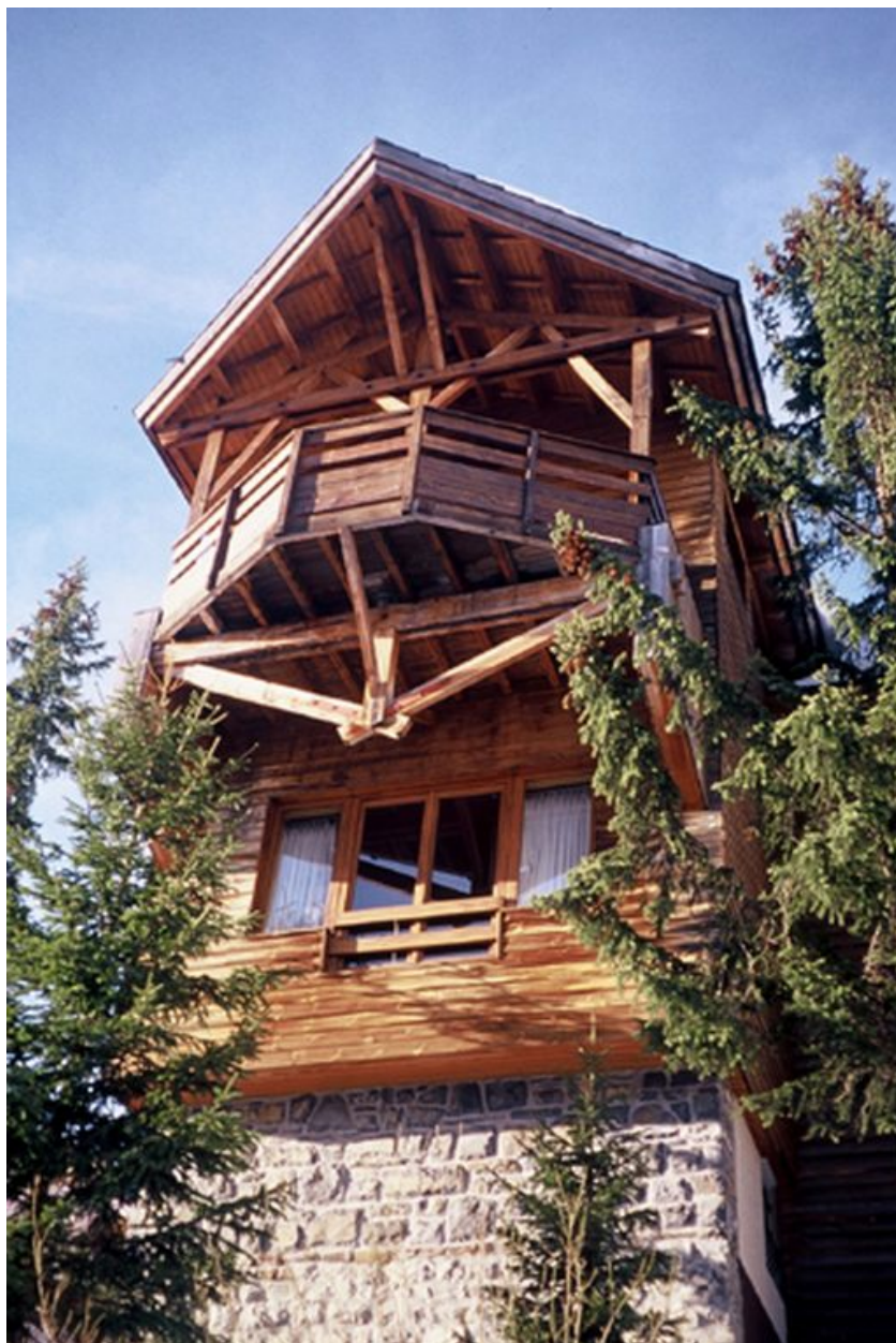
Elévation postérieure. Le balcon
