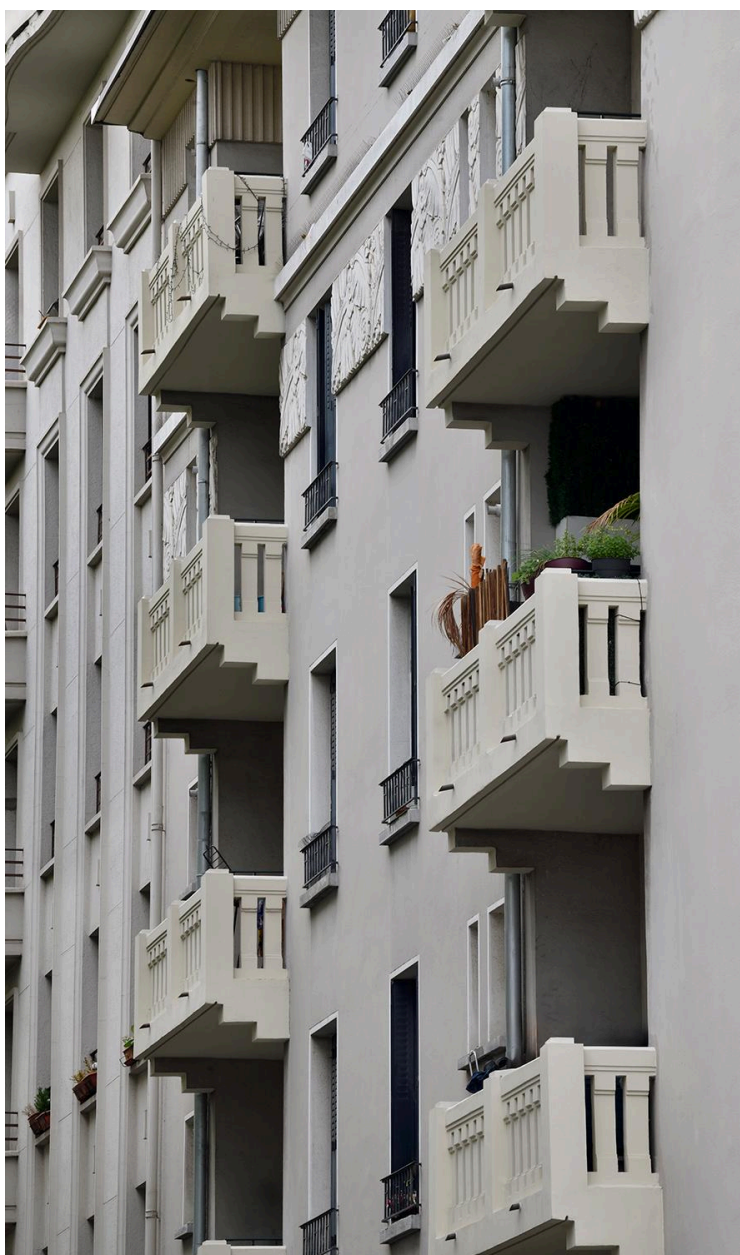
Elévation route de Vienne : vue partielle
