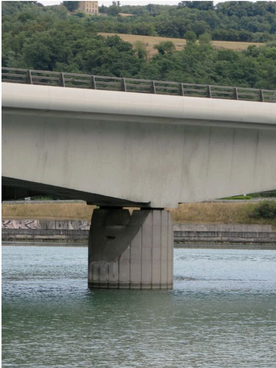
Pile, face aval (depuis la rive droite)
