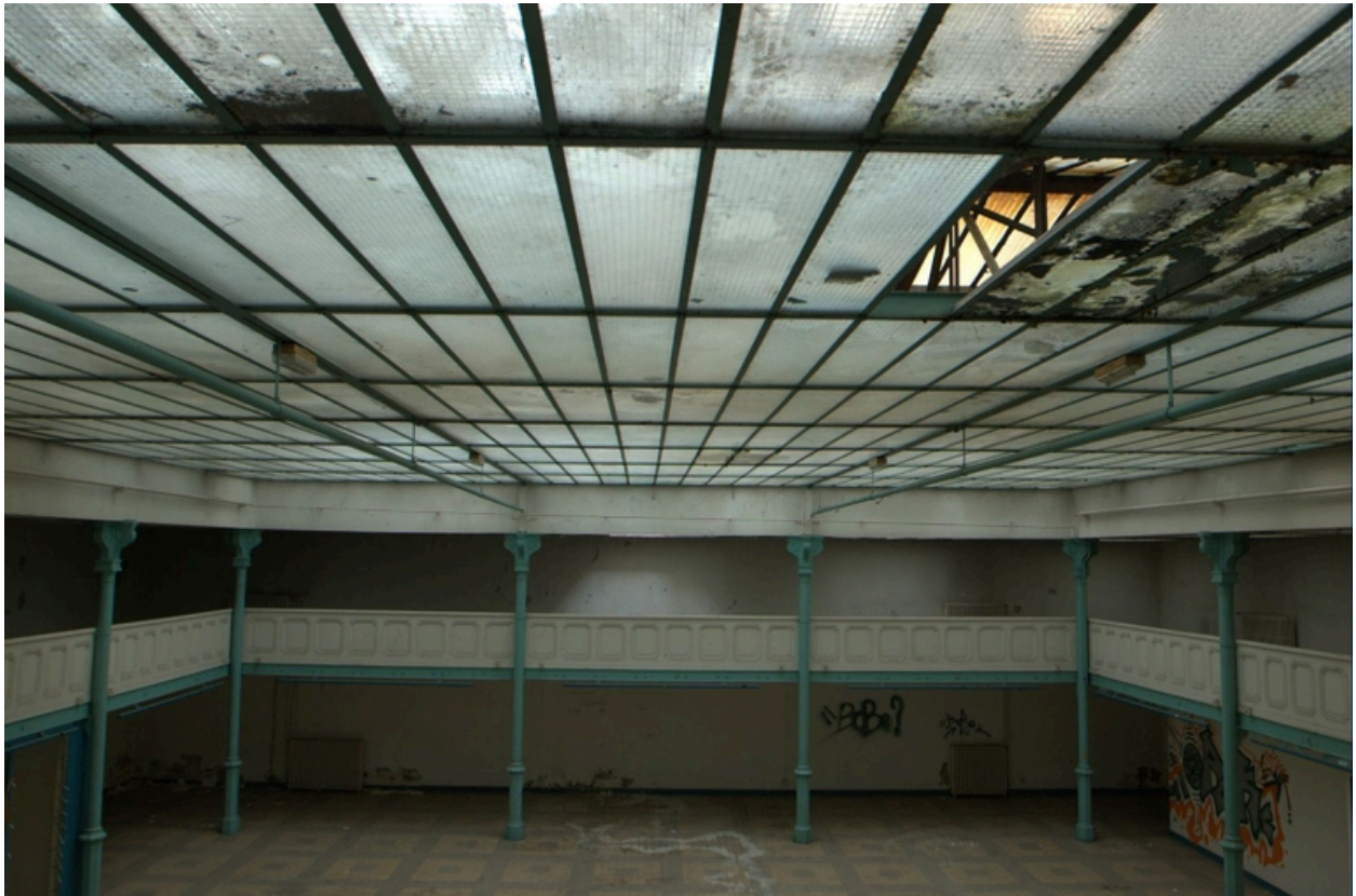
Vue nord de la halle
