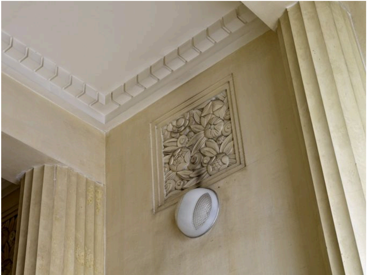
Détail du décor et du plafond du vestibule
