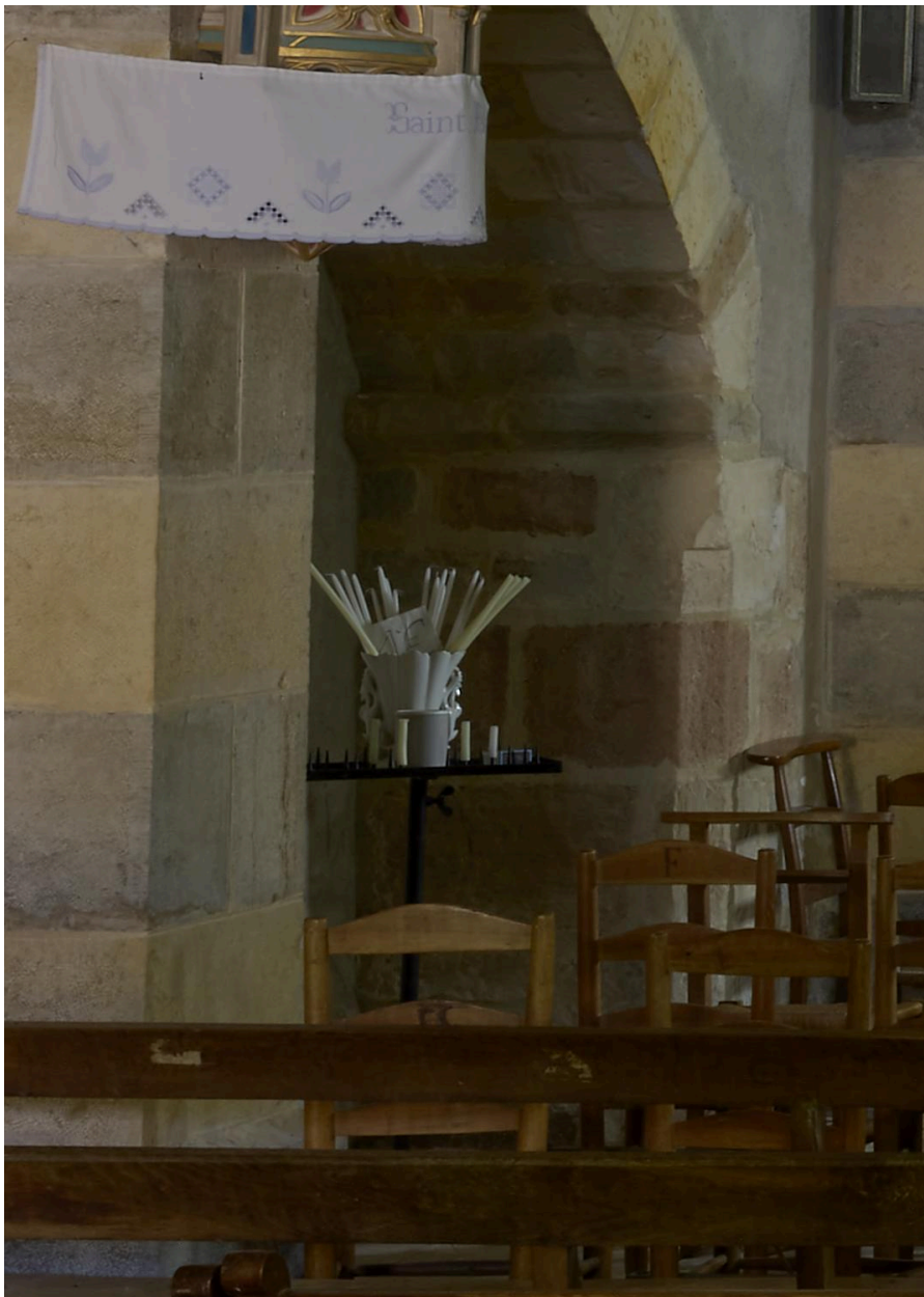
Vue de détail de la mouluration du piédroit de l'arc d'accès supposé à une chapelle disparue (troisième travée nord). Détail de IVR84_20230300151NUC4A.
