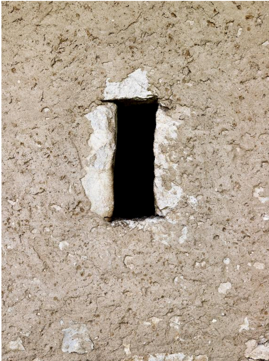
Détail du jour de l'étable sud et de l'enduit.
