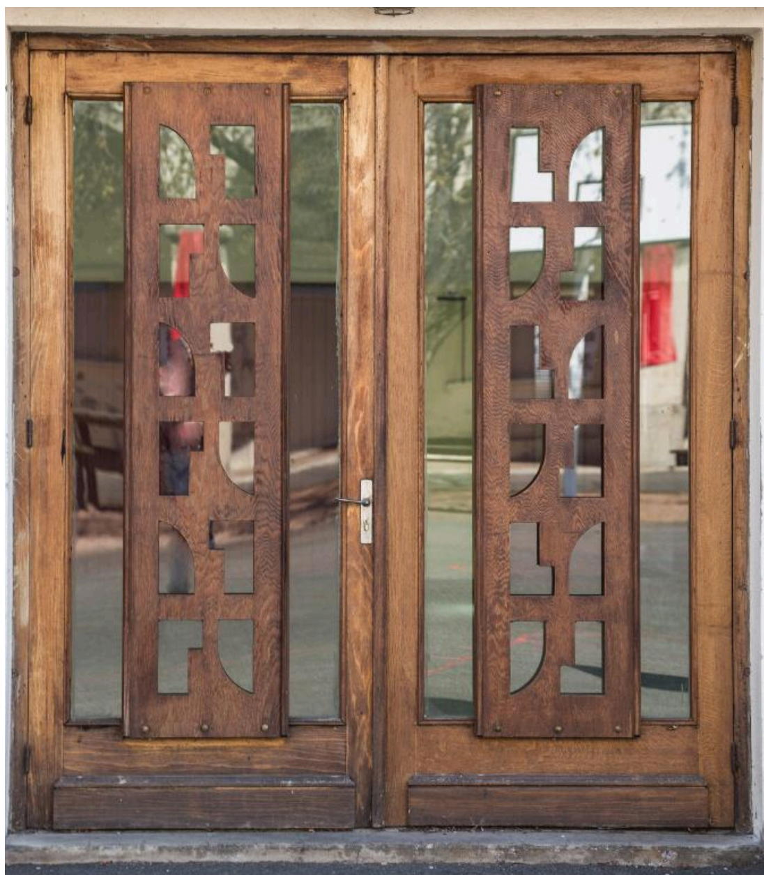
Gymnase. Hall d'entrée
