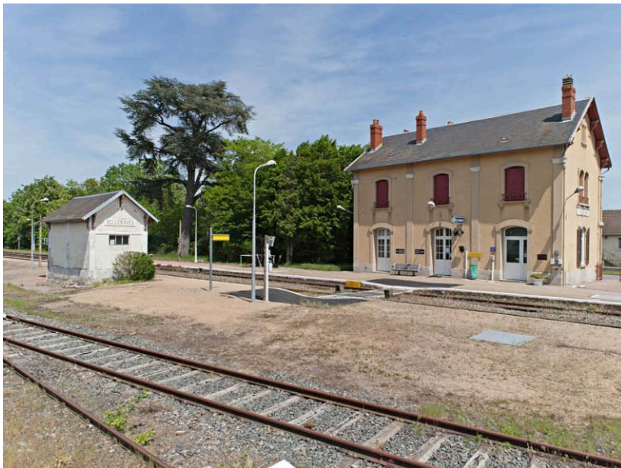
La gare de Belleval et l'abri des voyageurs (au lieu-dit la Charrière), côté voies.
