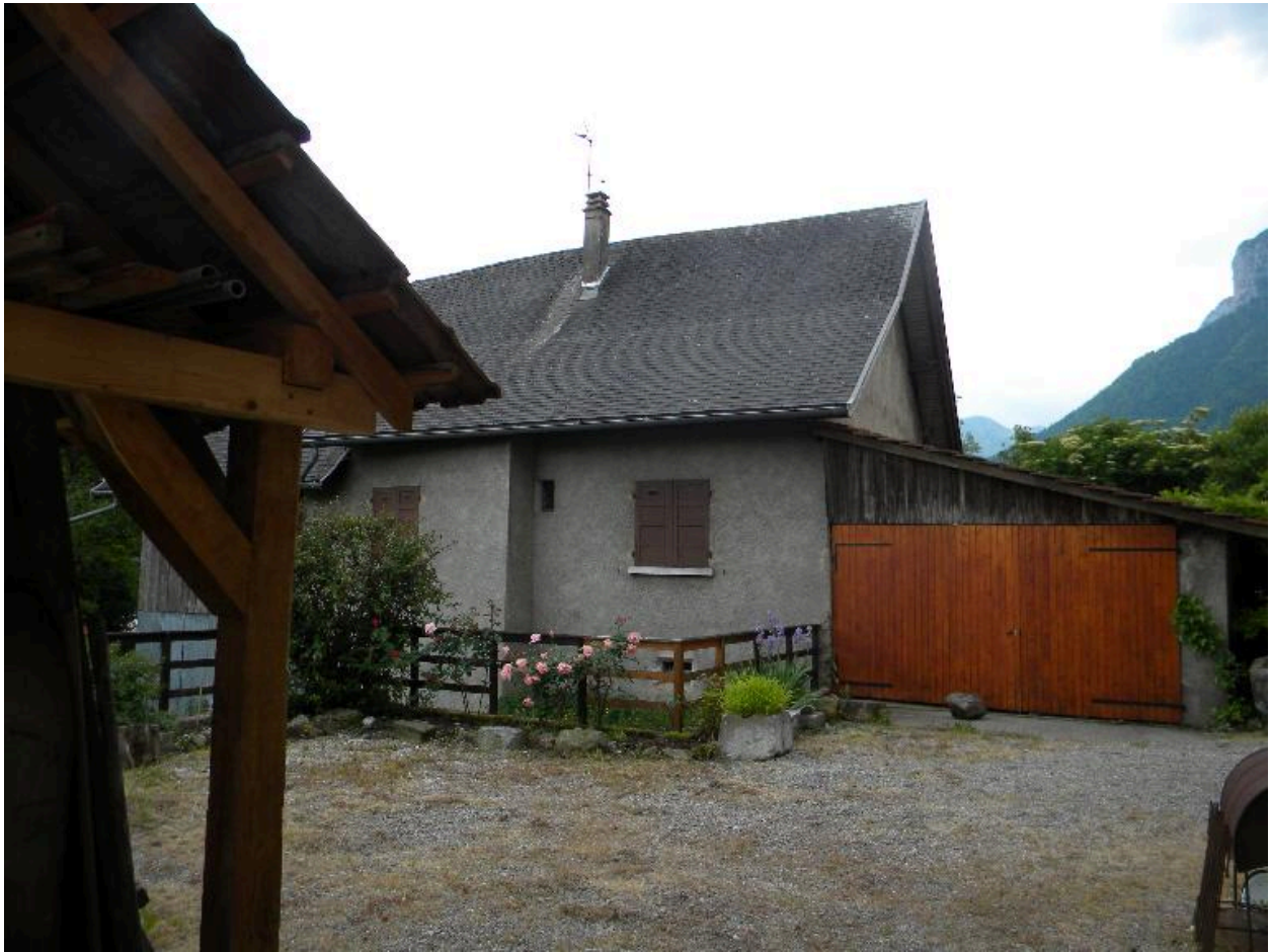
Vue de la façade nord d'une ancienne maison (2008 B3 561)
