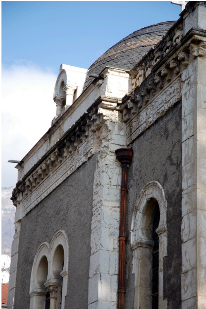
Elévation latérale ouest, vue partielle
